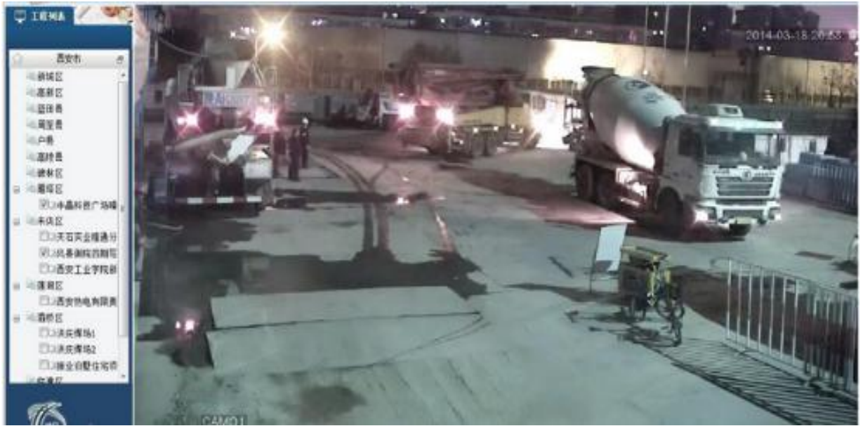
工地现场视频、图像采集监控
